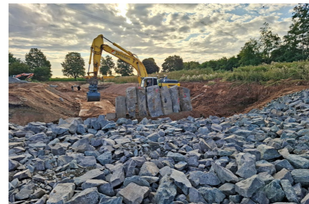
Einbau Steine Raugerinne
