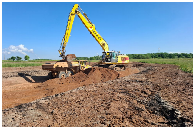
Bodenbewegungen zur Herstellung des neuen Gewässers
