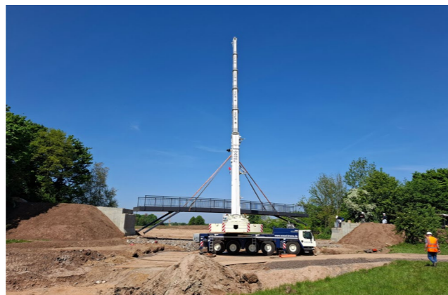
Einheben der Radwegbrücke
