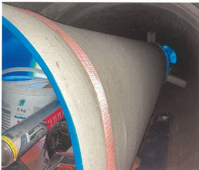
Rohreinzug Ei 500-700 in DN 1200
