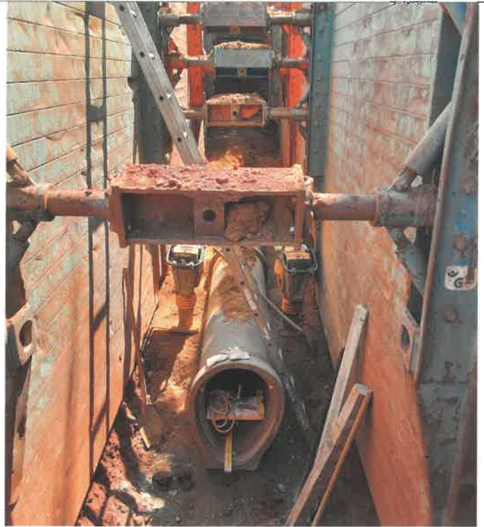
Kanalverlegung Ei | Fotos: Fischer Teamplan
