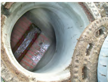
... und nach der Sanierung
