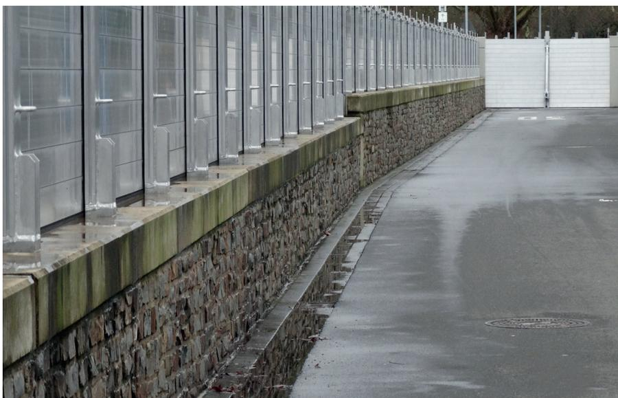
hinter der Hochwasserschutzwand angeordnete Entwässerung konnte die geringen Wassermengen, die sich durch die Dichtungen des mobilen Schutzsystems hindurchdrückten, problemlos aufnehmen. Auch die von uns geplanten neuen und sanierten Pumpwerke in Neuendorf und
