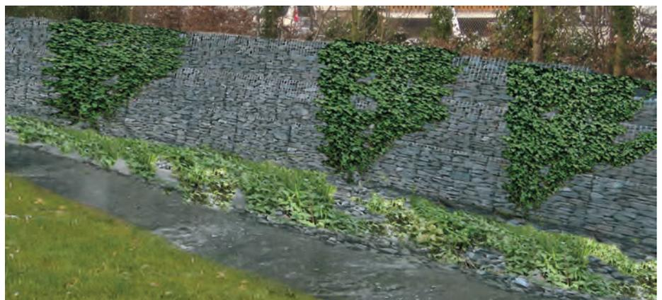
Visualisierung der Gabionenwand zur Ertüchtigung der Stützmauer
