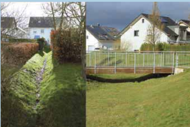
Abb. 7: BP 251 – zentraler Grünzug und Zuleitungsgraben
