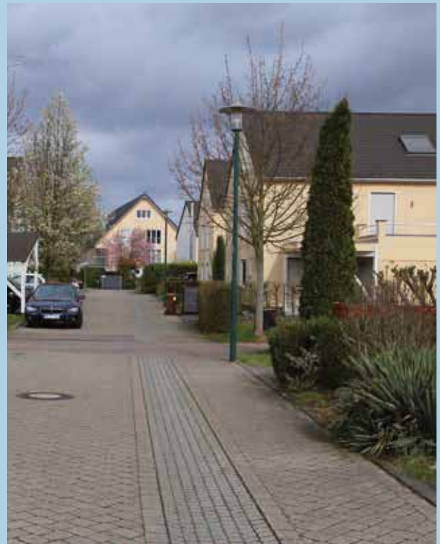
Abb. 5: Ablaufrinne im Straßenbereich
