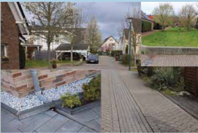
Abb. 6: BP 228 – Rinne im Straßenraum, Grundstückszuleitung und Versickerungsmulde
