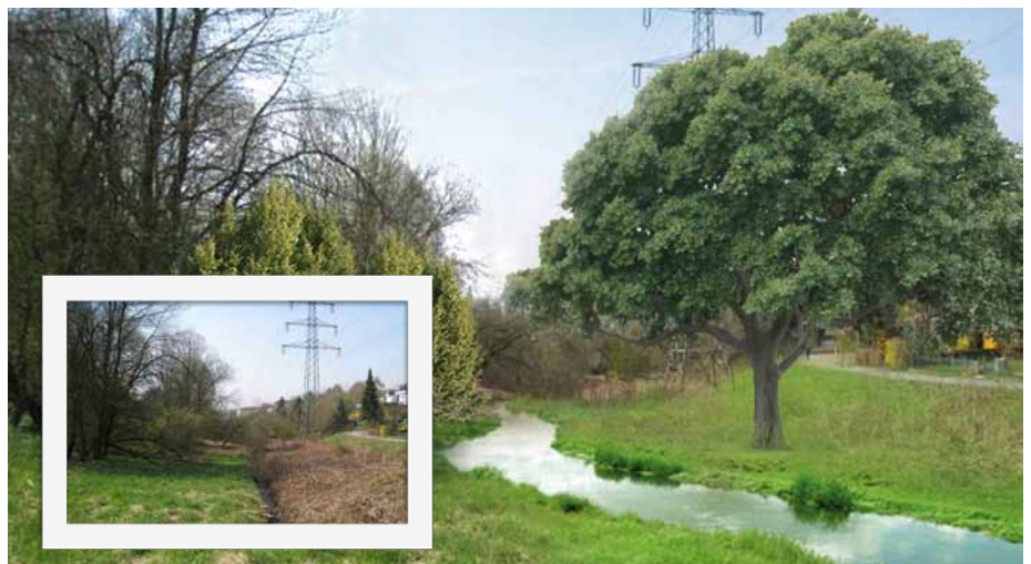
Kremenholler Bach - vor und nach der Umgestaltung
