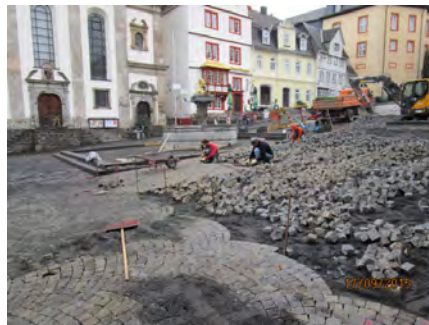
Alter Markt im Bau
