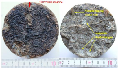
Bild 25: Bohrkern 14, Stirnseite mit teilweise abgeplatzter schwarzer Beschichtung und leichten bräunlichen Verfärbungen, Ausblühungen auf der Bruchfläche der Innenseite
