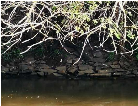
Ufersicherung der Erft bei Glesch im Ist-Zustand
