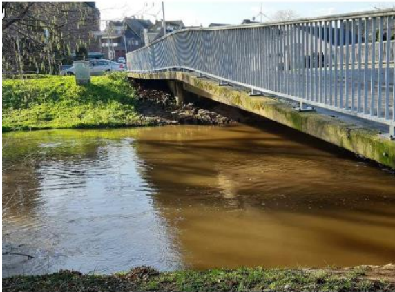
Brücke der Persinger Straße über die Erft
