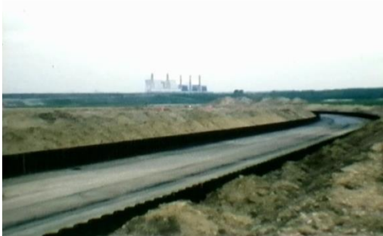
Erft und Braunkohlenbergbau Beispiel: 5-fache Erft-Verlegung im Tagebau Frimmersdorf
